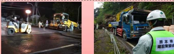
【通行不能の交差点での応急工事】【道路啓開(倒木、崩壊土砂の撤去)】
